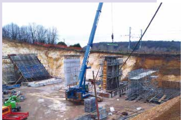
Étape 2 : construction des piédroits
