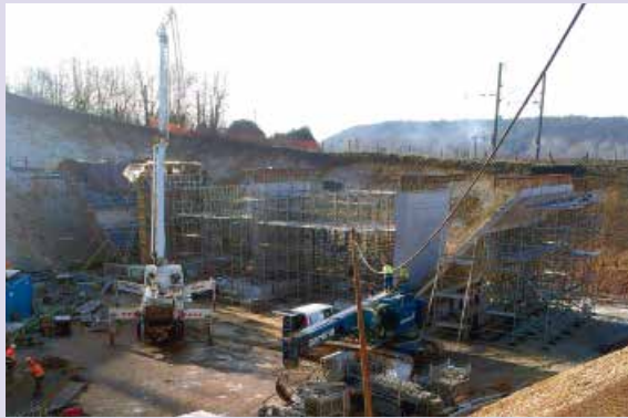
Étape 3 : construction des bracons
