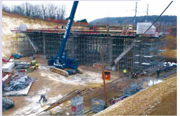
Étape 4 : construction de la traverse
