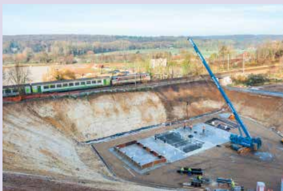
Étape 1 : construction des semelles de fondations
