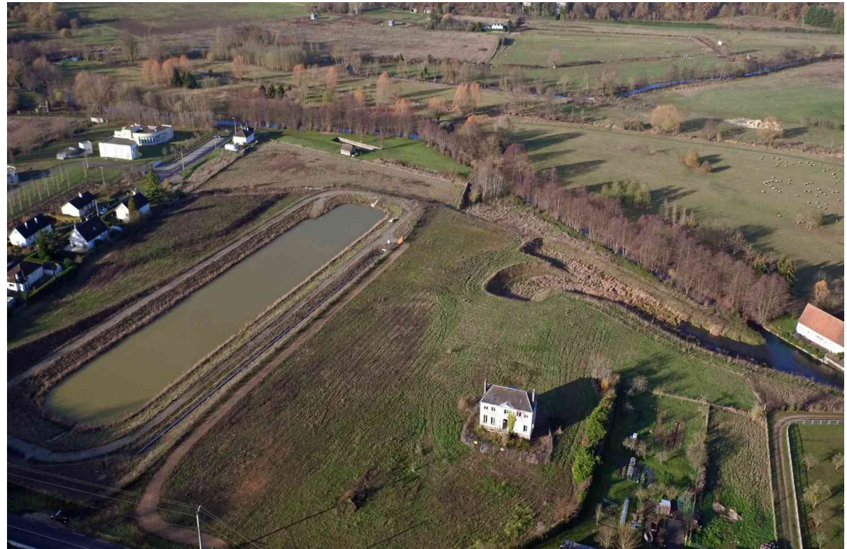
Bassin 2 et son exutoire
