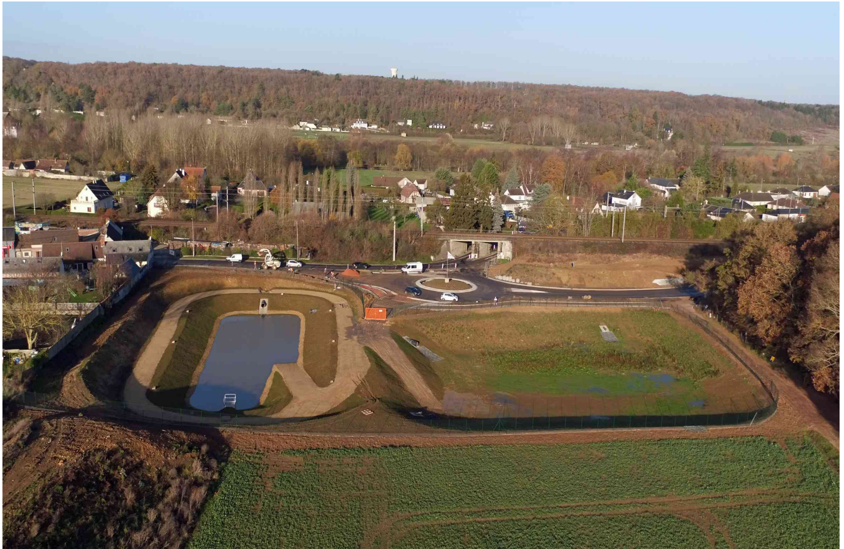
Construction du Bassin 2Ter et sa noue d'infiltration
