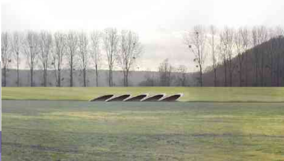
Ouvrage de décharge
