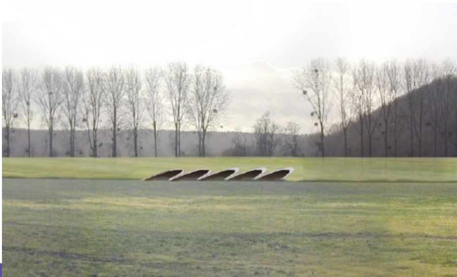
Ouvrage de décharge
