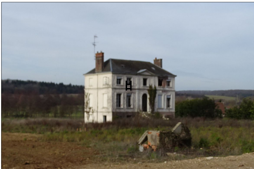
Déconstruction du « manoir »
